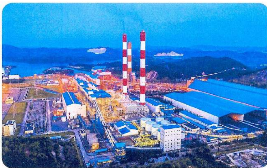
Hình 7.6. Nhà máy nhiệt điện Mông Dương I và Mông Dương II
